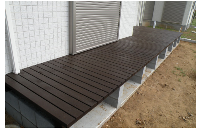
(ウッドデッキ塗装完成後)
